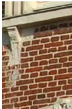
Joints au nu des maçonneries
