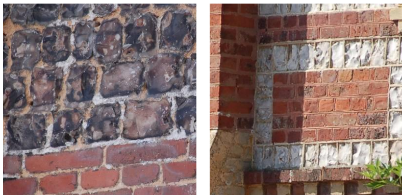
Brique et silex destinés à rester apparents
