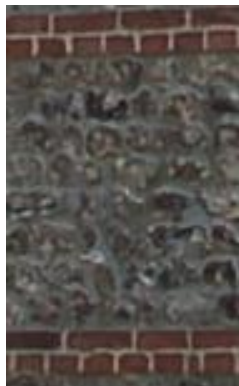
Joints au nu des maçonneries
