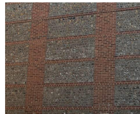
Le silex est utilisé en remplissage
