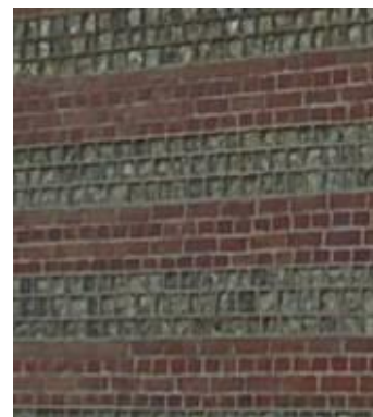
Chaînages en brique
