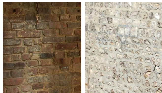
Brique et silex grossièrement hourdés, à enduire
