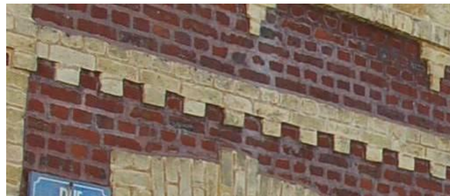
Appareillage de briques rouges et de briques jaunes silico-calcaire
