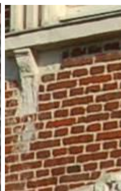
Joints au nu des maçonneries
