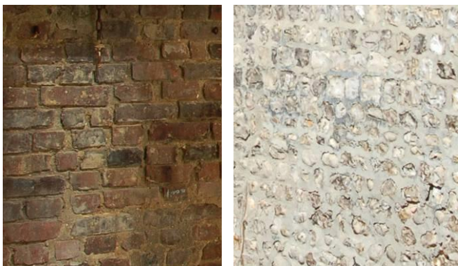
Brique et silex grossièrement hourdés, à enduire
