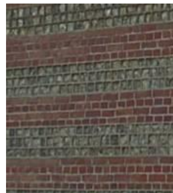
Chaînages en brique
