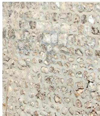
Brique et silex grossièrement hourdés, à enduire
