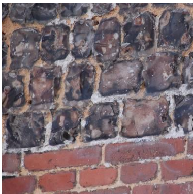
Brique et silex destinés à rester apparents
