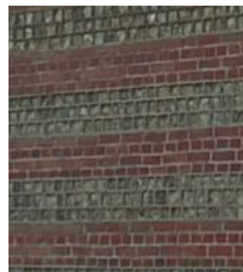
Chaînages en brique
