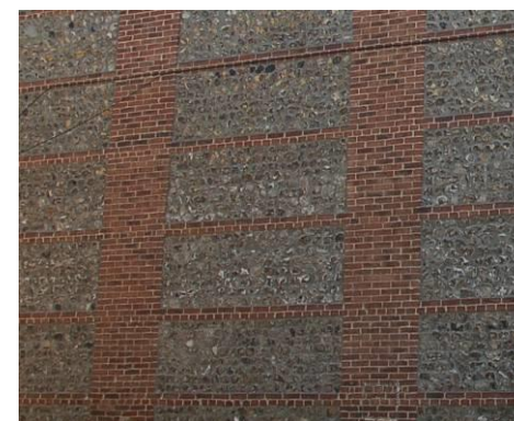
Le silex est utilisé en remplissage
