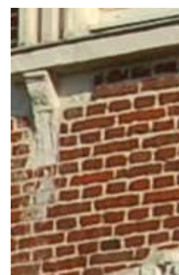
Joints au nu des maçonneries
