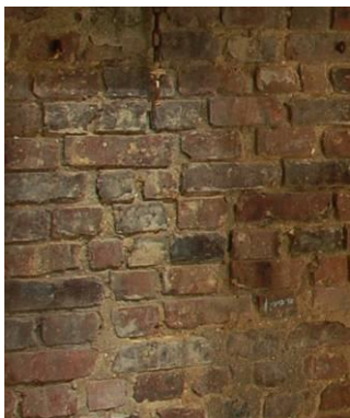
Brique et silex grossièrement hourdés, à enduire
