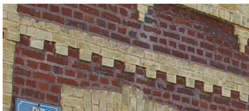
*Appareillage de briques rouges et de briques jaunes silico-calcaire*
